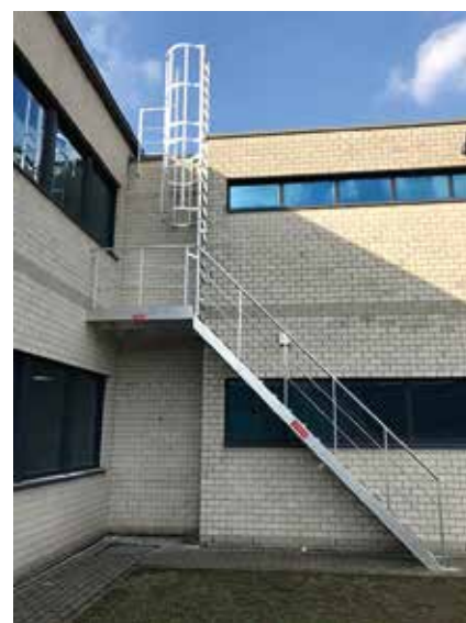
• Escalier + échelle à crinoline
